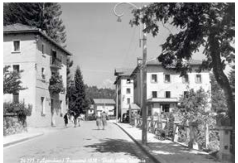
Cartolina (edizione Ghedina, anteriore al 1955) in cui si nota a destra il chiosco della "Cencia Bacana" per la vendita di frutta e verdura.
