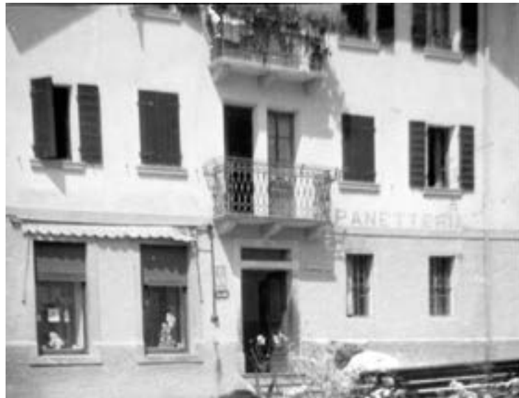
L'edificio in cui avevano sede la farmacia e il panificio di Barba Salva (foto agosto 1954).
