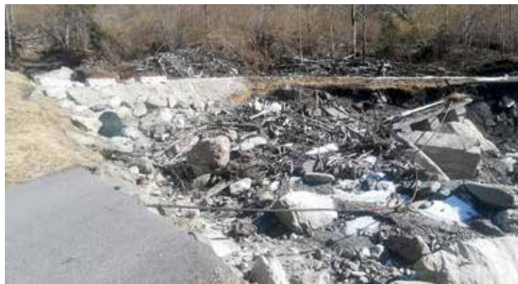
Ren. Il guado provvisorio approntato con il materiale accumulato dopo l'alluvione del dicembre 2020.
