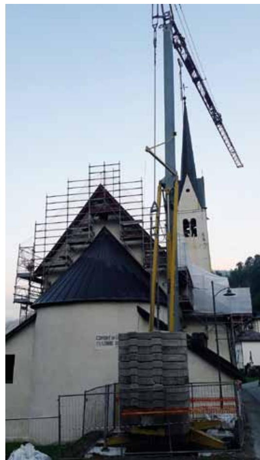
Un'immagine che ci riporta all'intervento esterno, il rifacimento della copertura in rame e la posa in opera del parafulmini.
