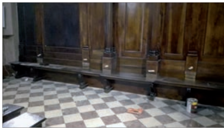
La posa delle nuove sedute, come in origine, in legno di noce.
